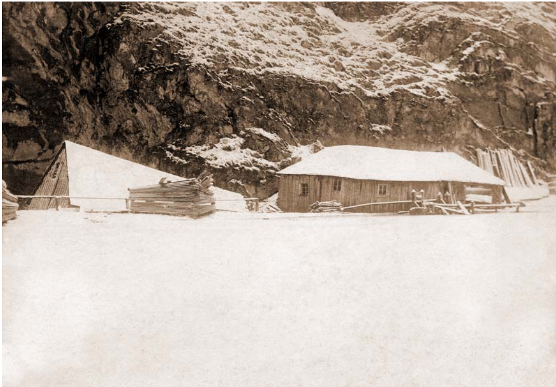
Scierie et moulin peu après les inondations de janvier 1883. Le tout ne sera plus jamais en fonction et bientôt rasé.
